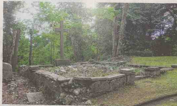
Bedroht vom Verfall: Die Grabanlage im Jahr 2013 FOTO: DETTMANN
